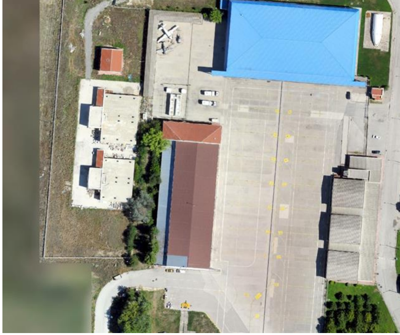
Şekil 16. Hava Aracı Bakım Merkezi Hangarları
