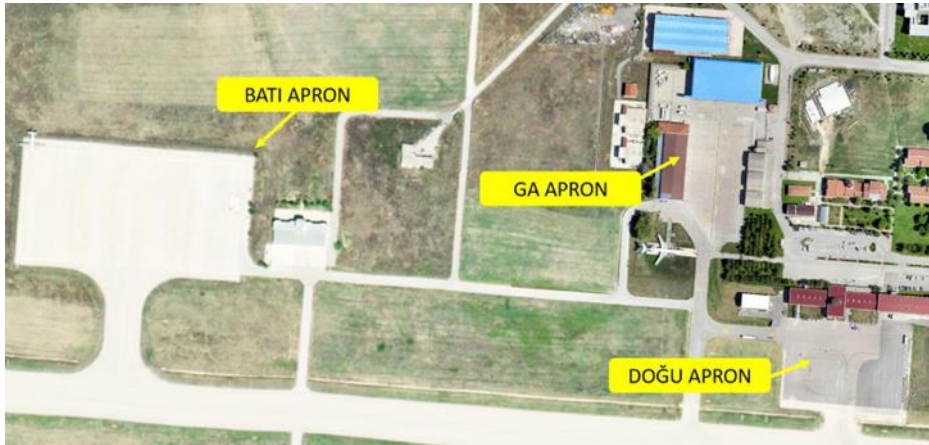
Şekil 6. Eskişehir Hasan Polatkan Havalimanı Apron sahaları
