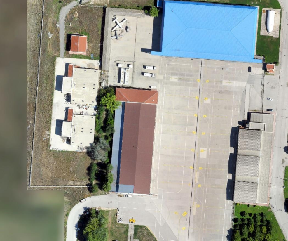
Şekil 21. Hava Aracı Bakım Merkezi Hangarları
