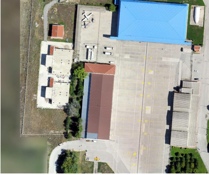
Şekil 21. Hava Aracı Bakım Merkezi Hangarları
